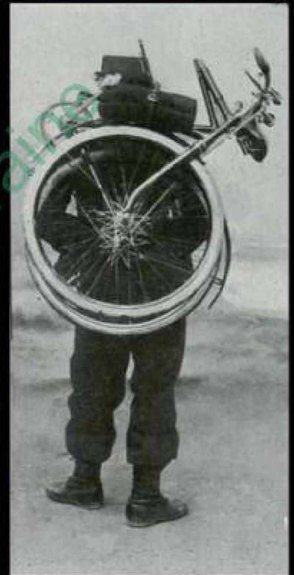
Elle fut inventée par le capitaine Gérard et utilisée durant les grandes manoeuvres de 1896. Elle se repliait en 35 secondes, roue contre roue. Son poids était de 11 kilos
